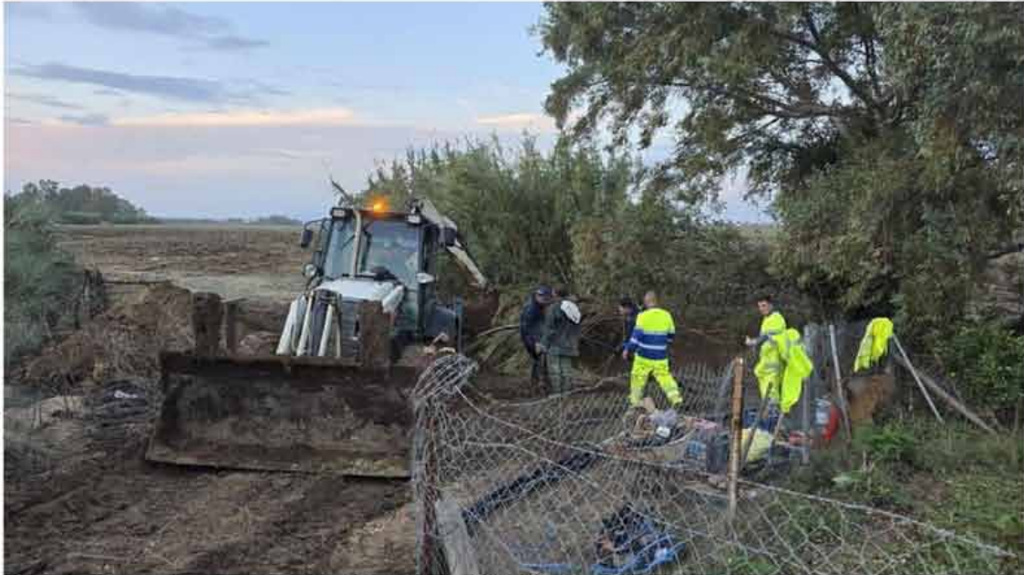
Operarios durante las obras de sustitución. / AYUNTAMIENTO DE SAN JOSÉ DEL VALLE
