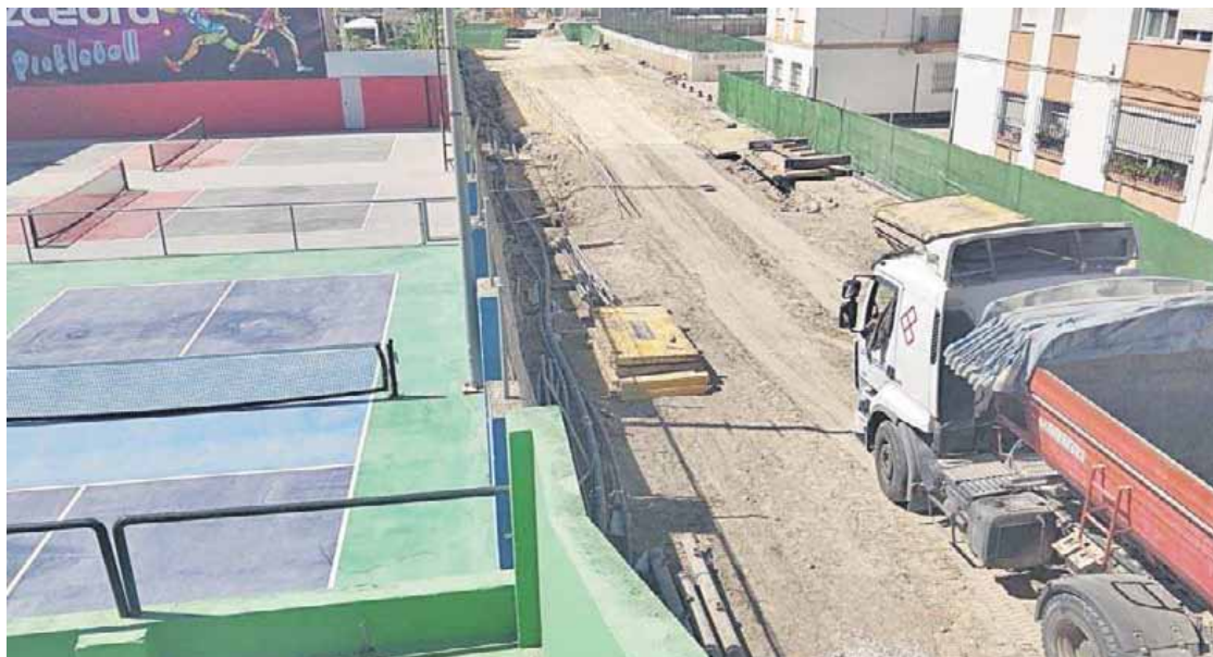
Las pistas de pickleball, llenas de polvo junto a las obras del tanque de tormentas en la avenida de la Bajamar.
