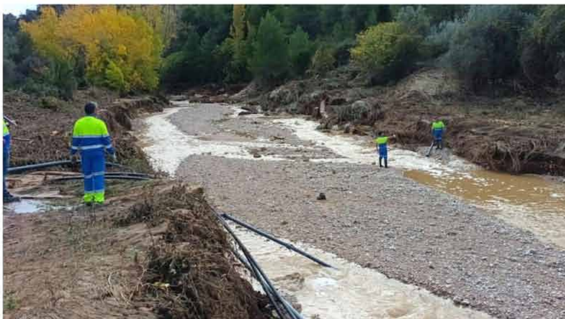
Trabajos de Aqualia en Letur.
