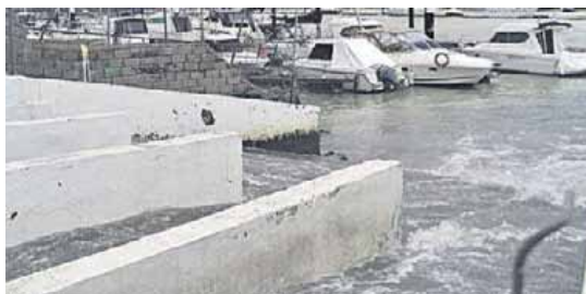
Aguas vertiendo el exceso de caudal al río Guadalete.
