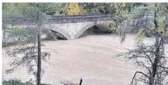
Puente en Lledó sobre un crecido río Algás.
